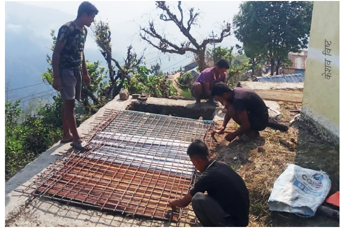
विद्यालय चर्पीको सेप्टिक ट्याङ्कीको स्ल्याब निर्माण गरिदै
