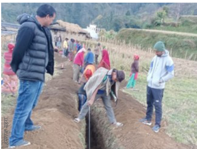
आयोजनाले ल्याएको उत्साह : स्थानीयहरू पाइप लाइन खन्दै
